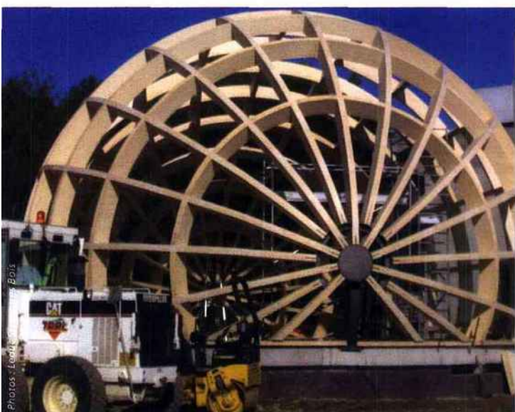
Montage de la structure bois.
