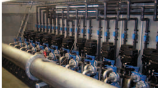
Refroidissement de lignes d'extrusion de plastique
